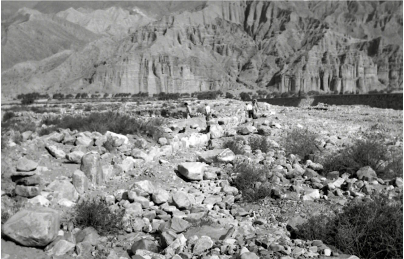
Construcción de defensas en el río Grande y el río Huasamayo con la Peñalta al fondo, en dirección E-O, sin fecha, colección AG.
