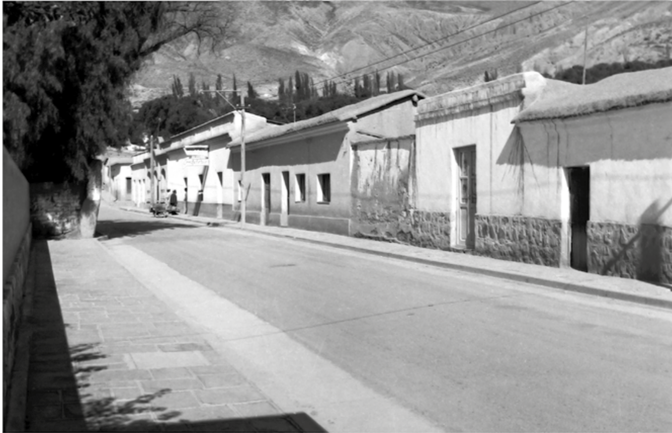
Calle Belgrano, entre Rivadavia y Alverro. Se observan la casa de las familias Rizo Patrón; Lizárraga, luego vendida a la familia Avellaneda-Saravia, y el Hotel y Confitería La Esperanza, sin fecha, colección AG.
